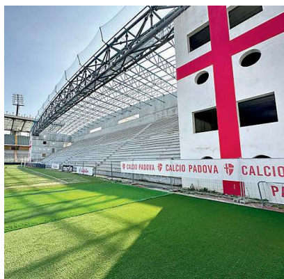
La curva Sud dello stadio Euganeo dove i lavori sono interrotti dal 2022
