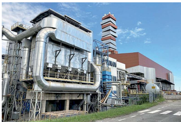
Il termovalorizzatore di San Lazzaro fornirà l'energia per riscaldare il nuovo ospedale a Padova Est
