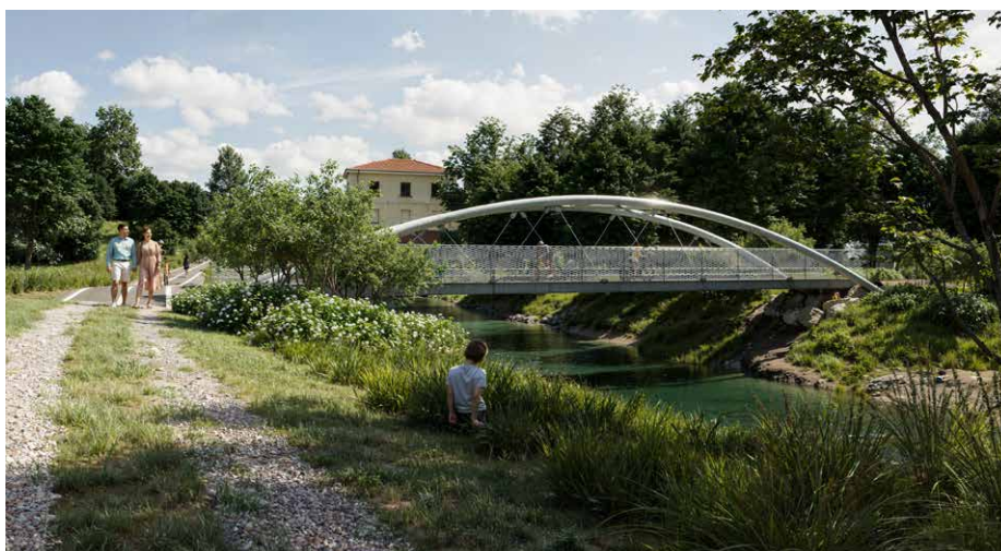
2. Vista del ponte sul Gravellone
