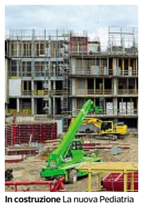
In costruzione La nuova Pediatria
